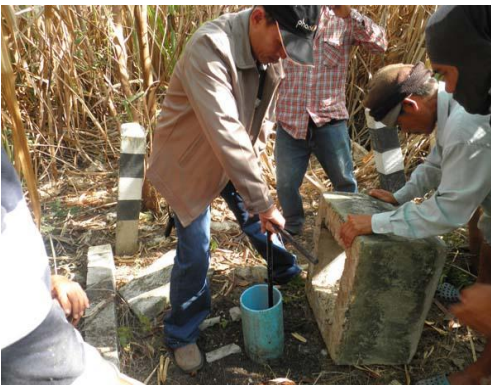
ภาพการปฏิบัติงานแก้ปัญหาน้ำไม่เข้าอ่างเก็บกักน้ำในพื้นที่ เดินศึกษาโครงสร้างตามแบบแปลน เปิดช่องระบายแรงดันอากาศและตะกอน
