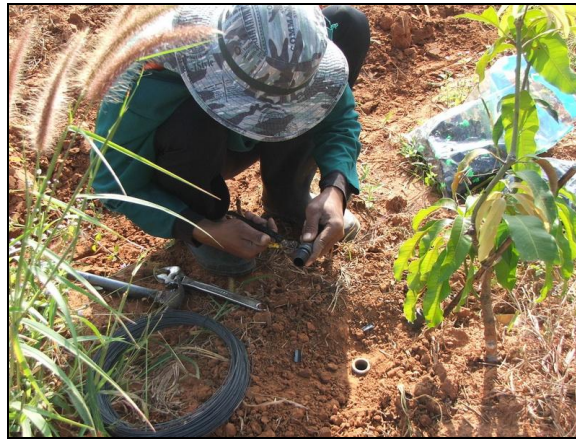
งานซ่อมแซมระบบน้ำแปลงมะม่วง
